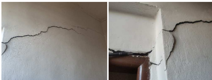
Obrázok 24 Viditeľné prejavy narušenej statiky
