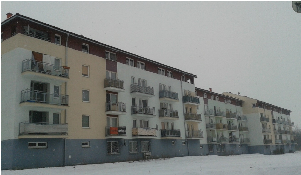
Družba V.-VII. (spolu 90 bytov); odovzdané prvým nájomníkom v 11/2011
