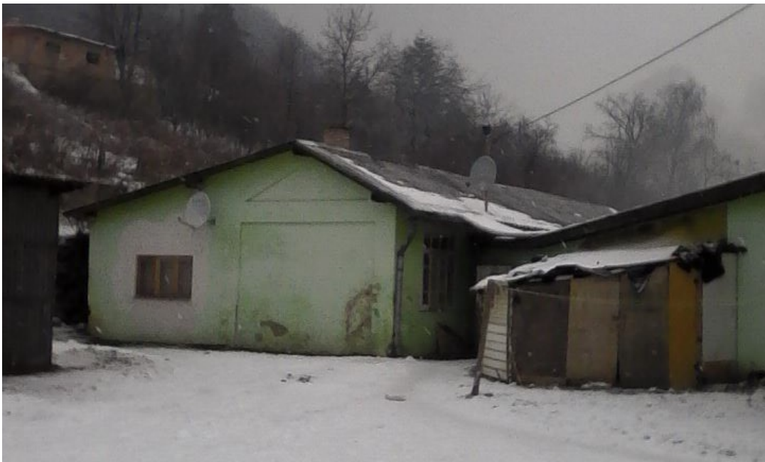
Rožňavská Baňa č. 176 (spolu 2 byty)
